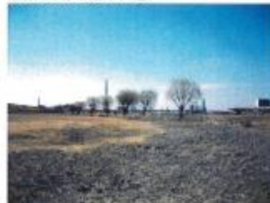
堤防寄りから見た下流部
